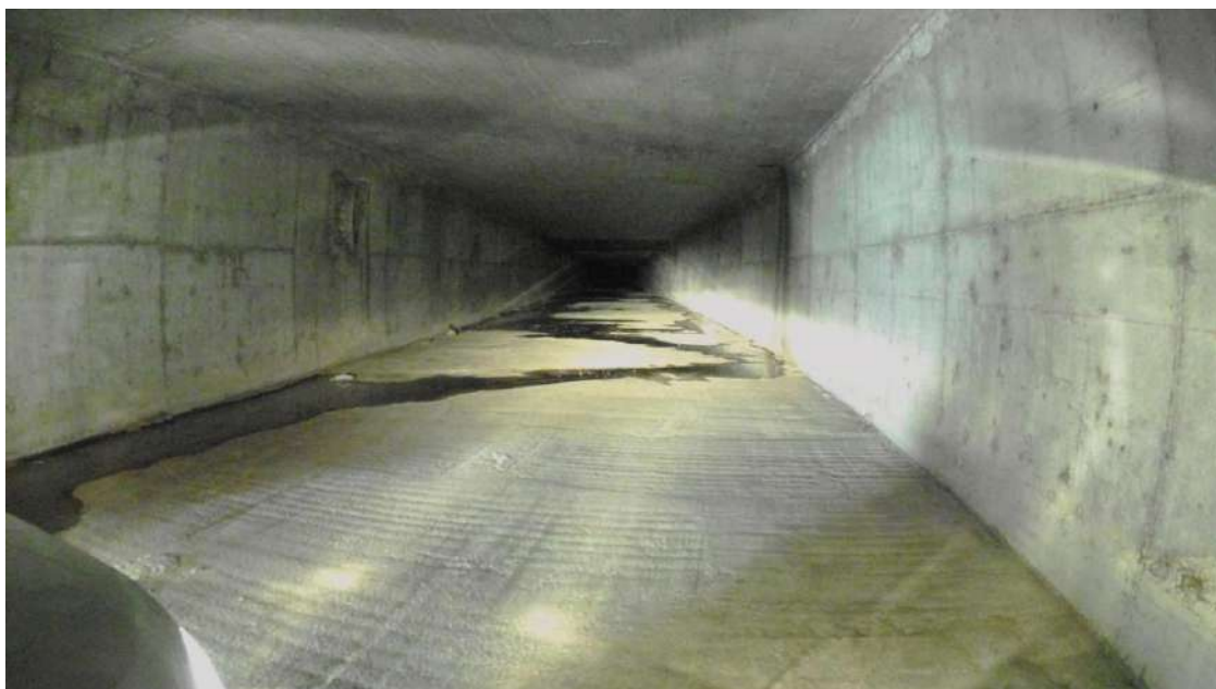
Túnel intermedio que ayuda en el desvío del Arroyo de Argamasilla / El Correo
