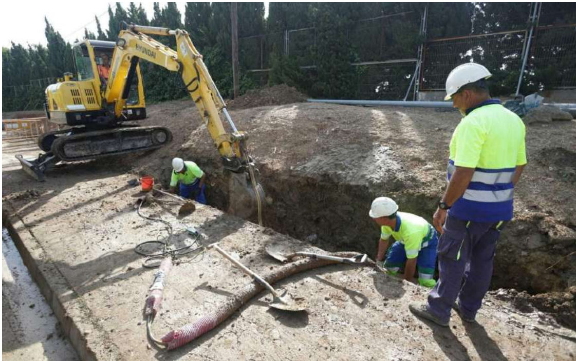
Operarios de Emalgesa trabajan en una avería en Algeciras.
