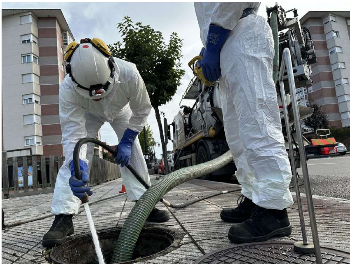
Trabajos para desatranchar las conducciones.
