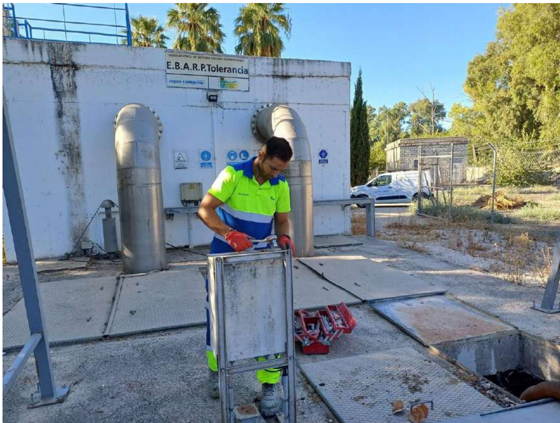
Operario de Aqua Campiña durante el mantenimiento en la estación de bombeo de Tolerancia / El Correo
